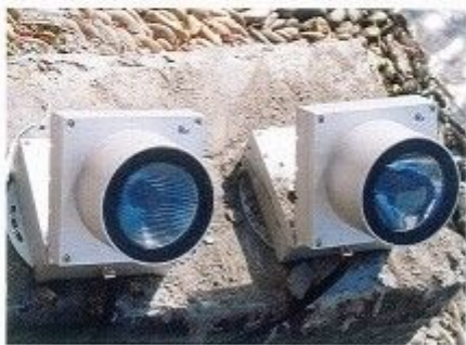
取得相同效果的两个灯具，具有不同的亮度和出光形式。左灯配带10°x60°光束角透镜罩，右灯配带8°窄角射灯罩
